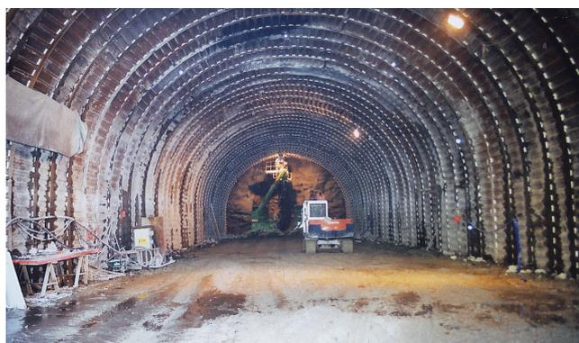
Cette photo montre les cintres qui confortent les parois creusées avec une infiltration de ciment entre les arceaux et la roche. (Photos BAP)
