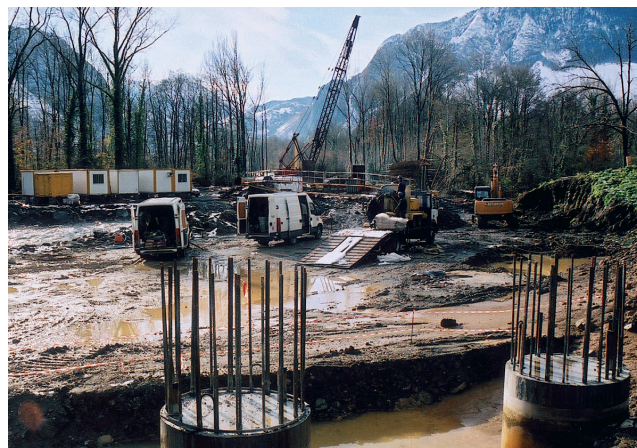
Les entreprises réalisent les travaux préparatoires à la construction du pont sur le Gave. (Photo BAP)
