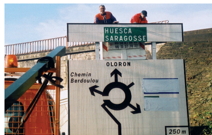
La pose des panneaux de signalisation annonçant l'ouverture de la déviation. (Photo BAP)
