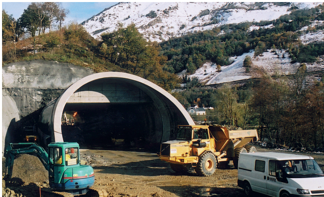
Le tunnel d'Osse est en voie de finition à Bedous. (Photo BAP)
