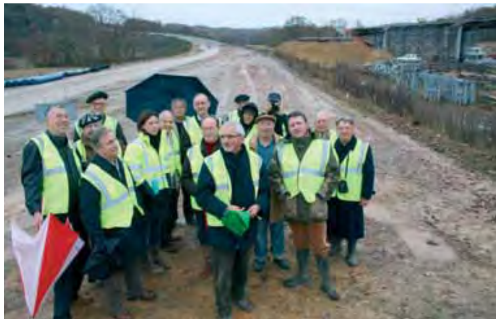
Les administrateurs et membres de commission de BAP sur le chantier de l'A65 à Aire-sur-l'Adour (photo BAP)
