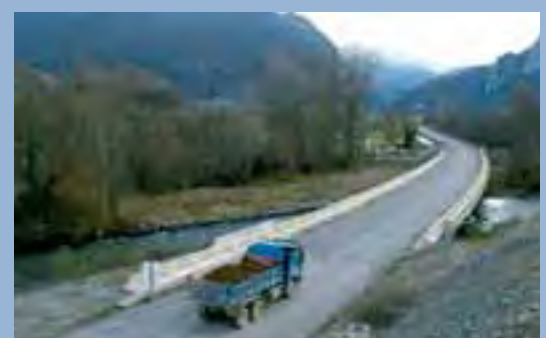
La route à la sortie du tunnel d'Osse est pratiquement achevée. (Photo FDC)
